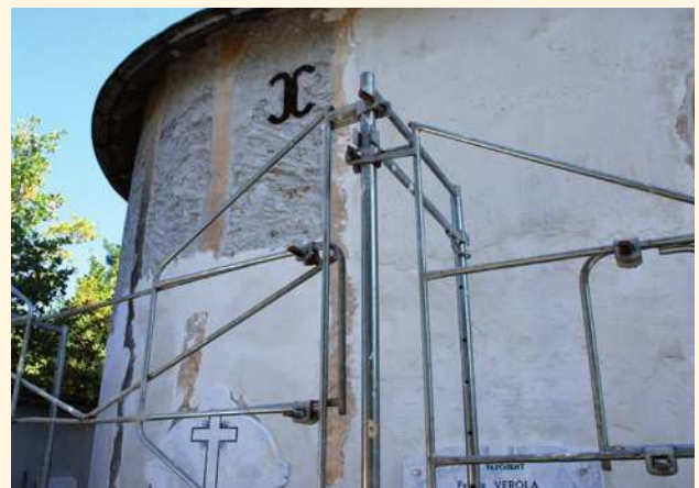
DECAOUTAGE DE LA FACADE ET POSE DE LA 1 er COUCHE DE CHAUX
