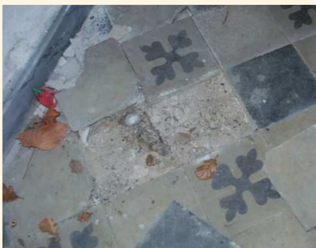
LE CARRELAGE AVANT SON REMPLACEMENT
