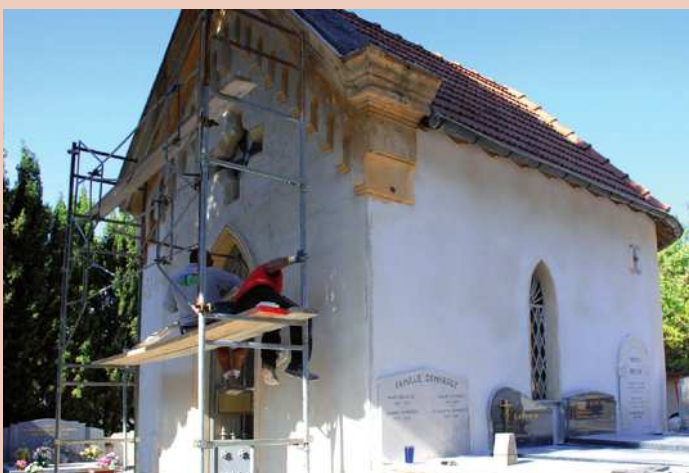
POSE DE LA 3 ème COUCHE ET MISE EN COULEUR
