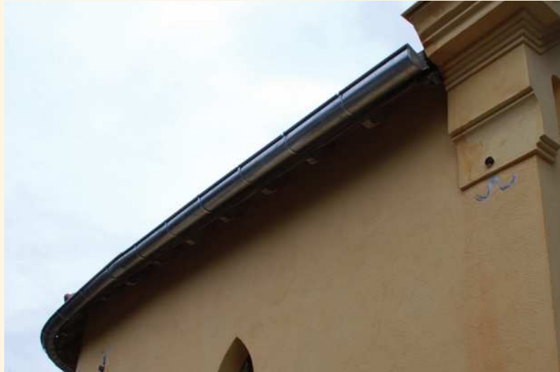
POSE DE LA NOUVELLE GOUTTIERE
